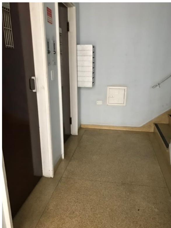
Foto 6- Hall de elevadores no andar.
